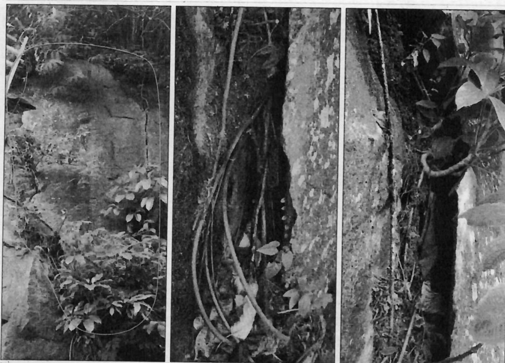
Figura 4 – Fotos obtidas em 26/04/2023 mostram-lasca rochosa aos fundos da Câmara Municipal. Notar presença de vegetação na fratura entre a lasca e o talude rochoso.
