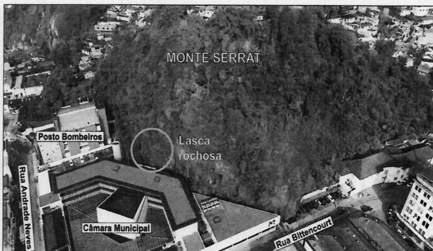
Figura 1 – Foto de junho de 2018 mostra localização de lasca rochosa com risco de queda no trecho de encosta do Monte Serrat aos fundos da Câmara Municipal. Notar proximidade entre a edificação e o paredão rochoso.
