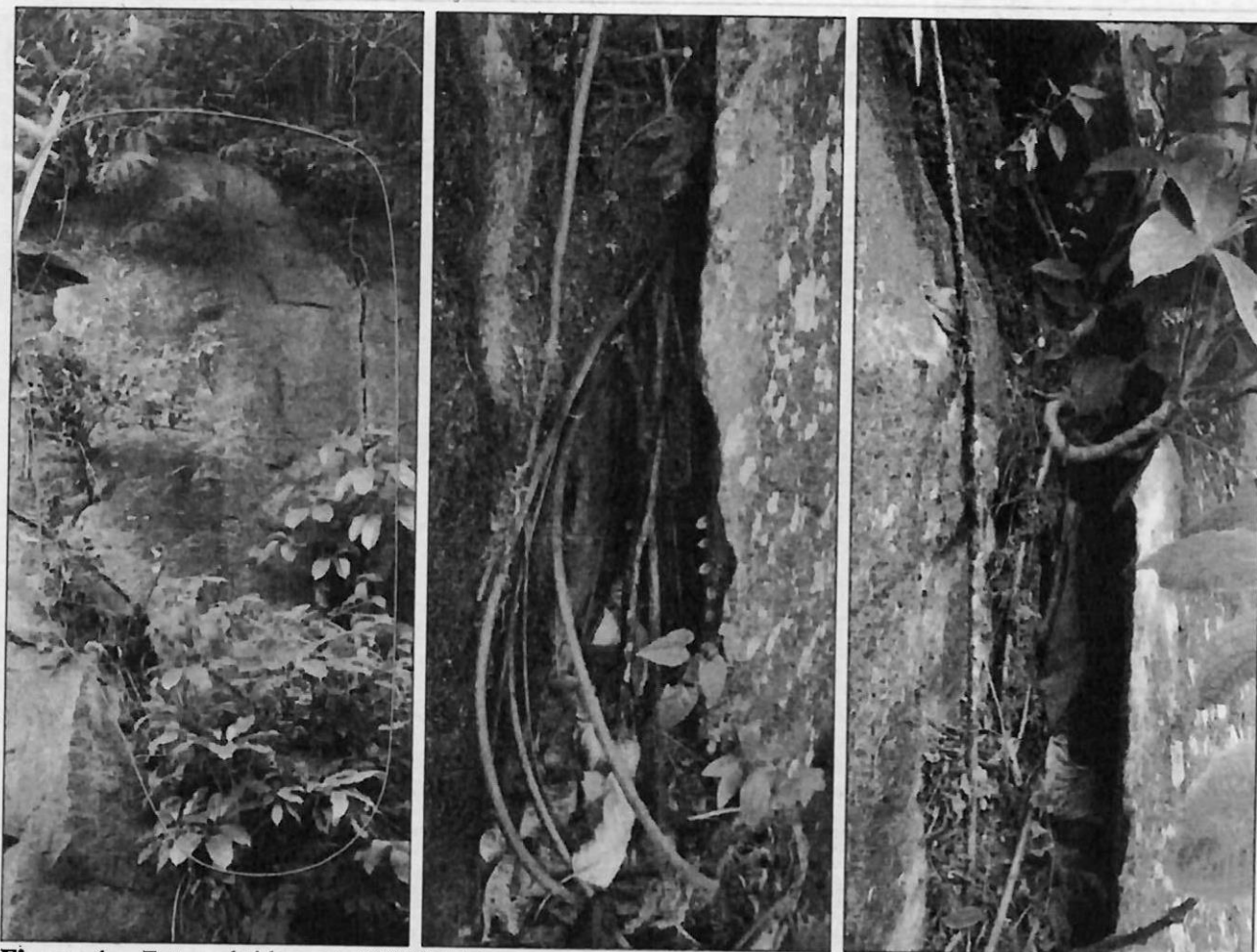
Figura 4 – Fotos obtidas em 26/04/2023 mostram lasca rochosa aos fundos da Câmara Municipal. Notar presença de vegetação na fratura entre a lasca e o talude rochoso.
